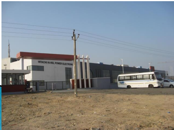
左写真:グジャラート州サナンド 日立製作所パワーエレクトロニクス工場
